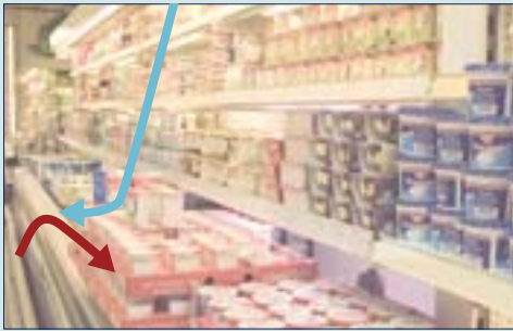
Falsche Stapelung lenkt den Kälteschleier aus dem Regal
