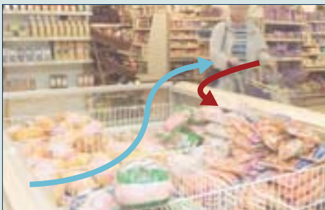
Überschreiten der Stapelhöhe leitet die Kaltluft aus der Truhe
