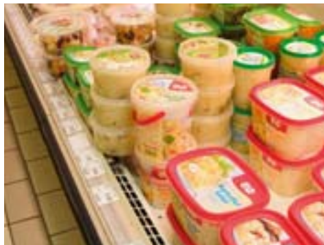
Behinderte Luftzirkulation durch Ware und Schilder
